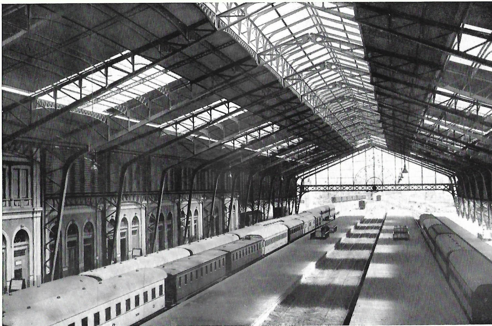
« Hall » da Estação de Alexandria
