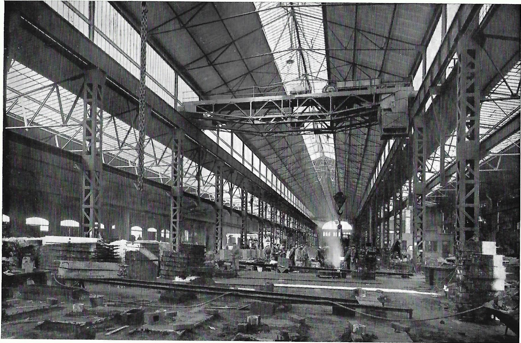
FABRICO DE AÇO : Oficina de fundição
