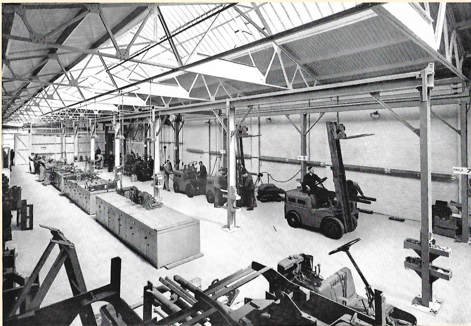
CONSTRUÇÃO NA OFICINA DOS TRANSPORTADORES CLARK
