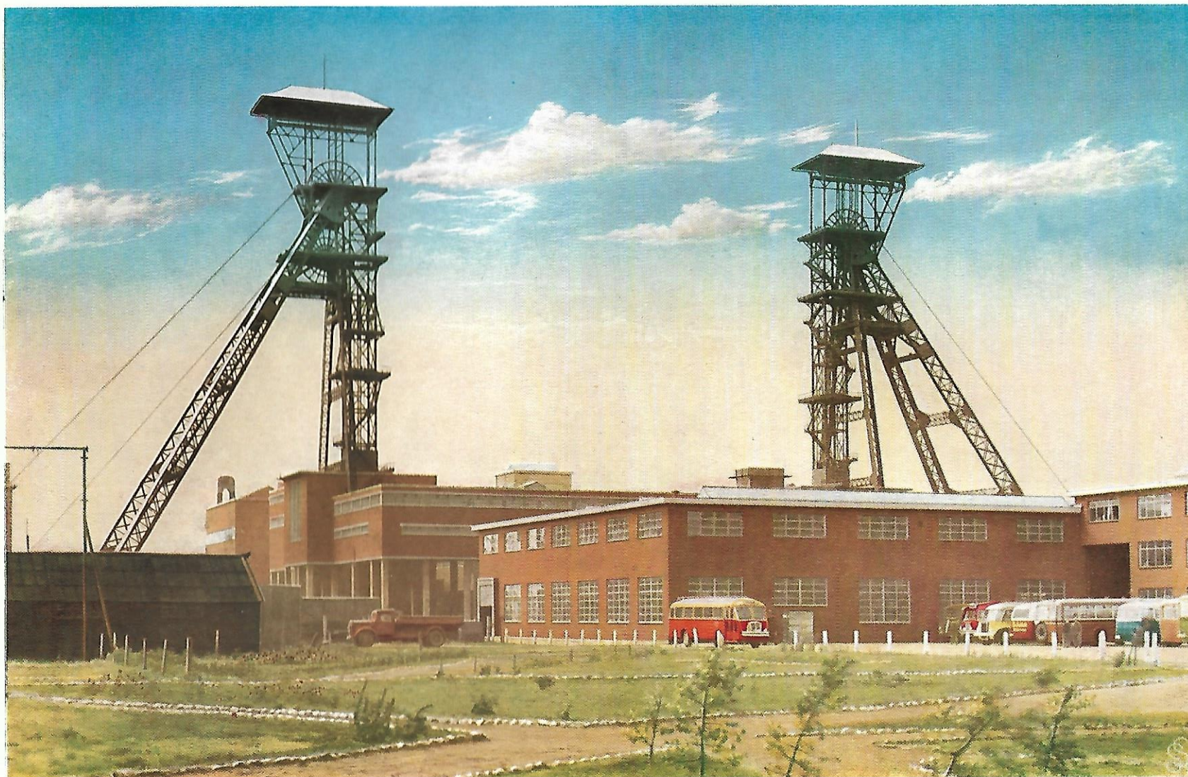
MINAS DE CARVÃO DE HOUTHAELEN : Chassis com rodízios sistema Köpe de 71,200 m. de altura
